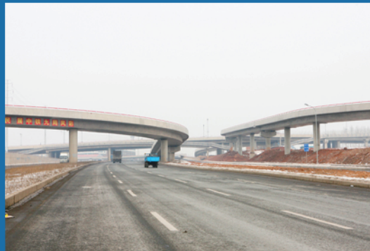
四环路道路桥梁工程 (全长67.2公里)
