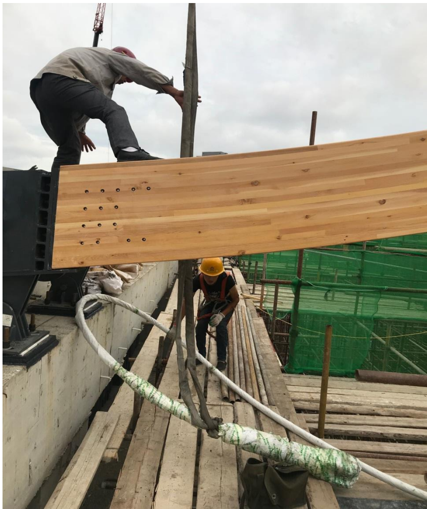
长春市全民健身游泳馆改建工程
