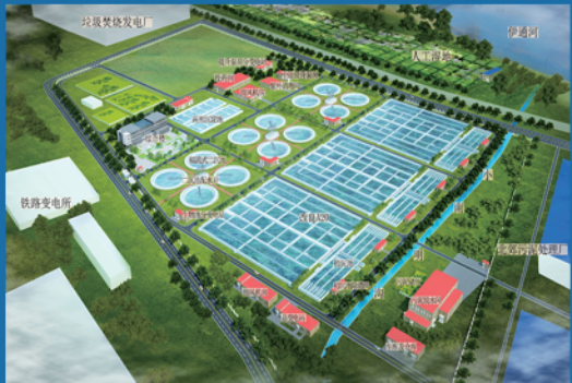
北郊污水处理厂鸟瞰图 (建成后日处理能力78万吨)
