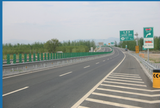
北京六环路勘察工程
